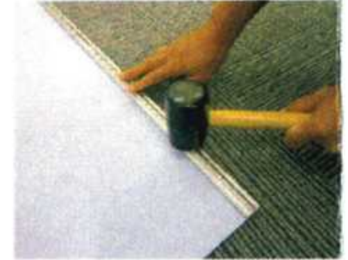
⑤ ゴムハンマーなどで上部バーを叩き閉める。
